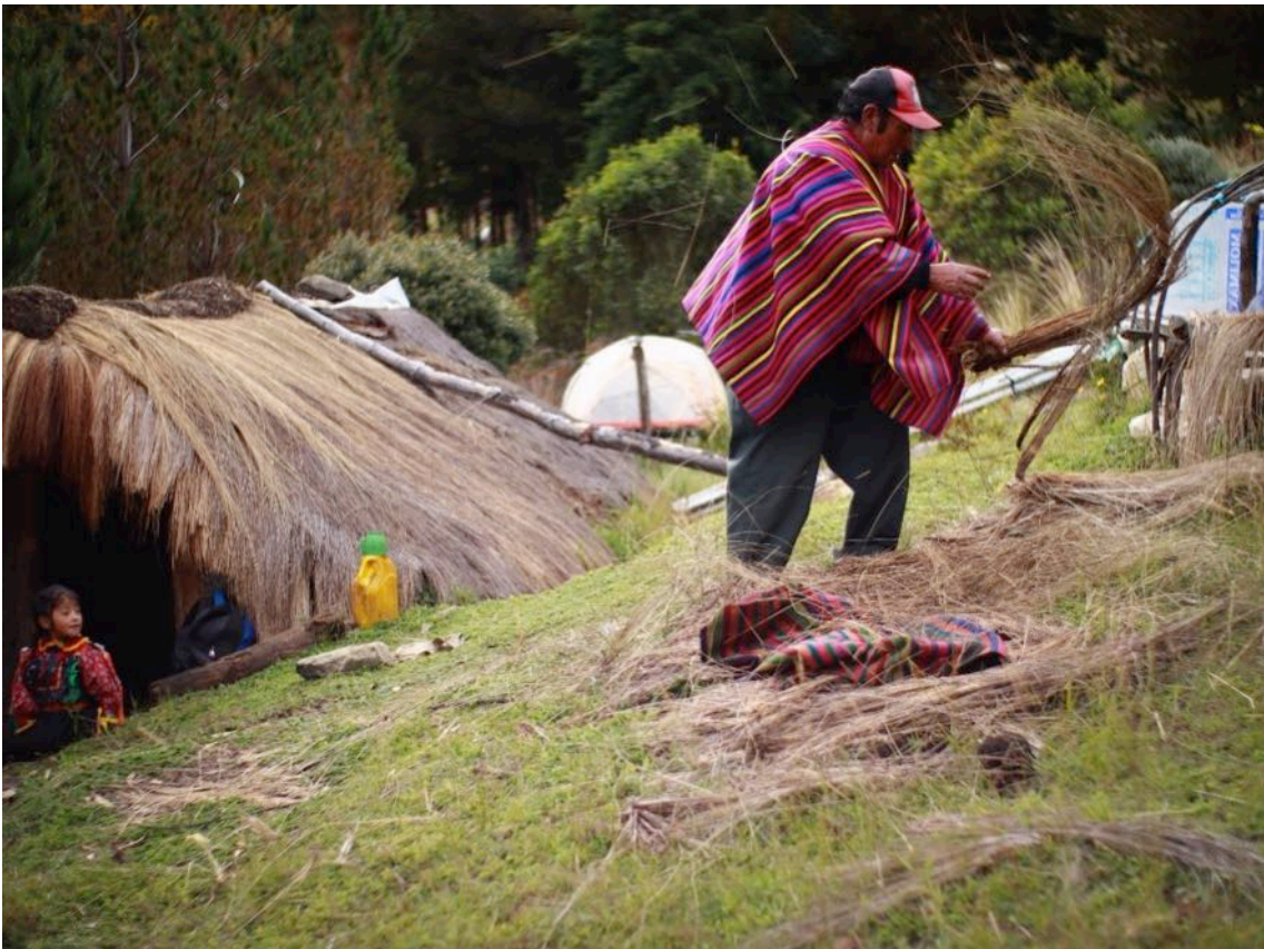
Figura 18. Secado del ichu para el techado de la casa.
