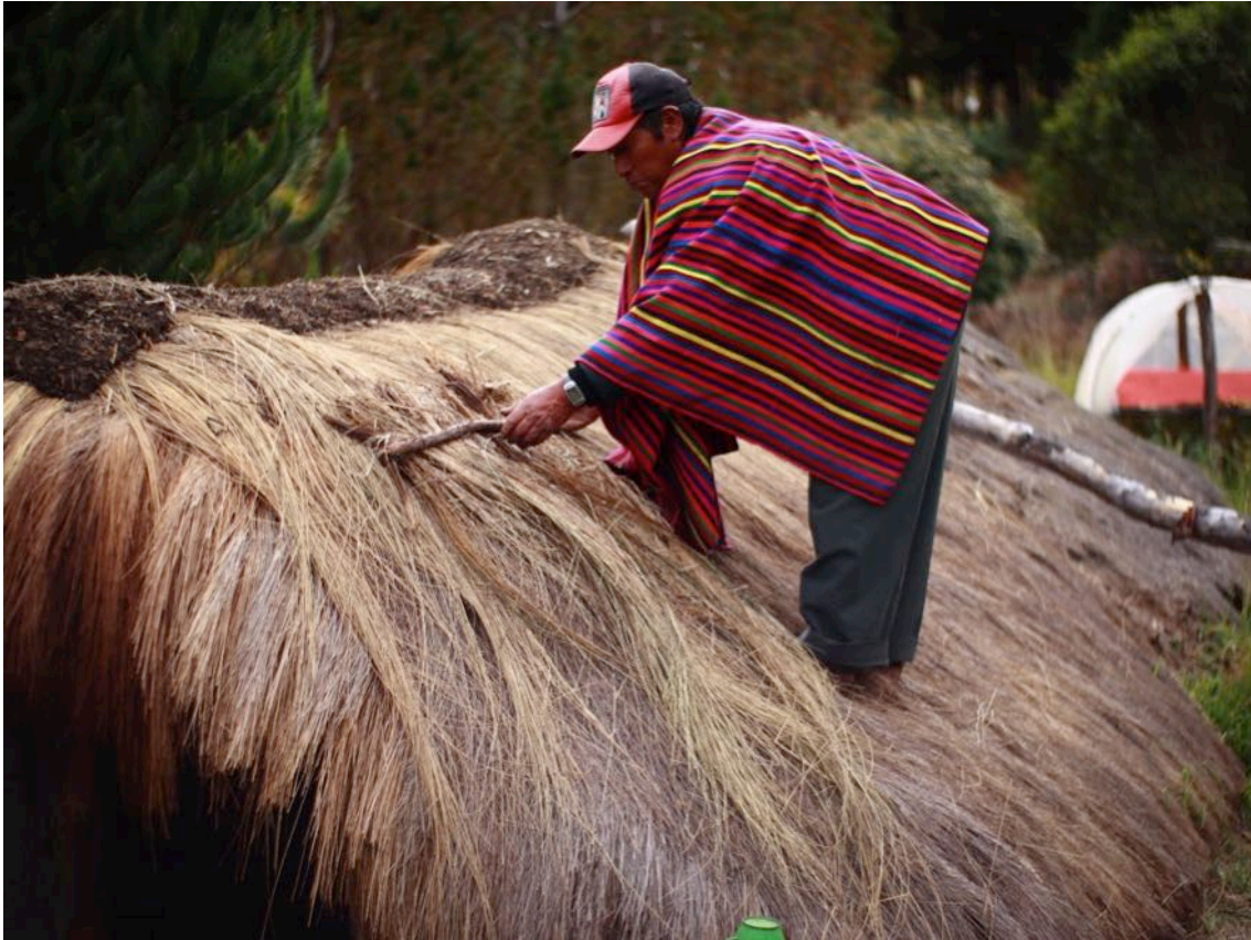
Figura 19. Colocación del ichu para el techado de la casa.
